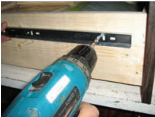
شکل ۷-۳۶ نصب ریل بر روی بدنه‌ی کشو
