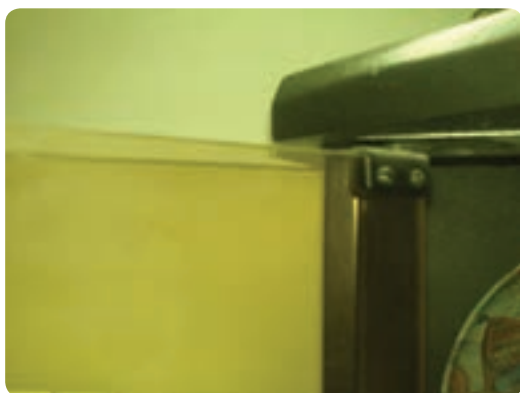
شکل ۶-۴۰ در شیشه ای با لولای پاشنه ای
