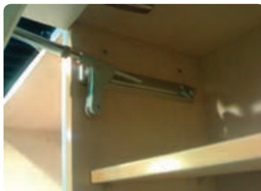
شکل ۶-۳۷ در کابینت نصب شده با نگهدارنده پمپی
