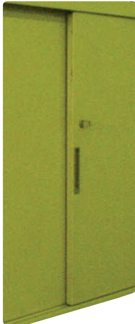
شکل ۶-۳۰ در کشویی با دستگیره توکار
