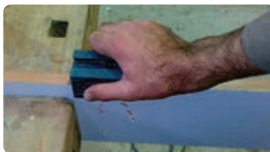
شکل ۶-۸۲ پرداخت لبه اضافی روکش
