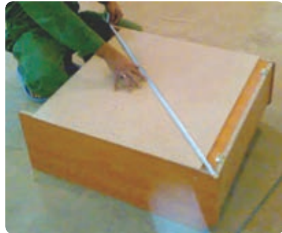
شکل ۶-۱۳۰ کنترل دویدگی کابینت
