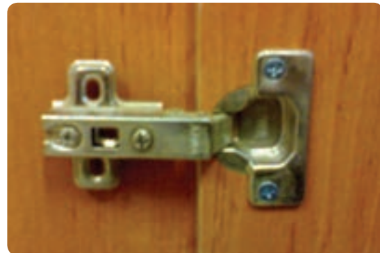
شکل ۸۵-۶ نصب کاسه لولا روی در کابینت
