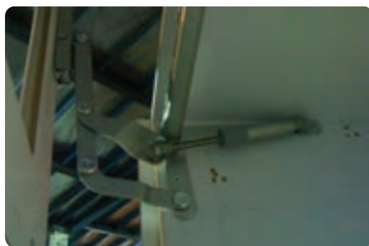
شکل ۶-۳۸ در کابینت نصب شده با جک اتوبوسی
