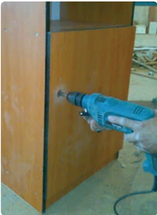
شکل ۱۲۳-۶ در آوردن جای قفل سوئیچی
