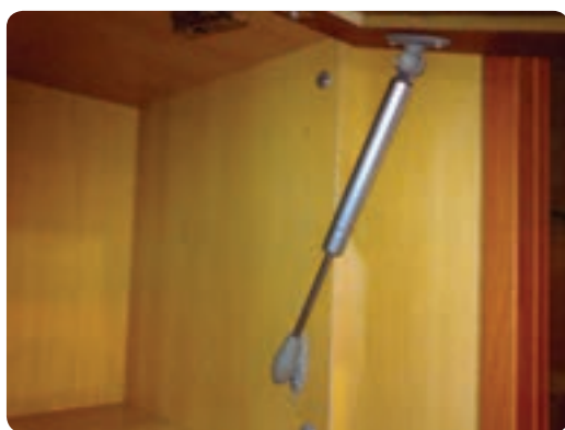
شکل ۶-۳۶ درِ کابینت با درجه یا نگه‌دارنده پمپی
