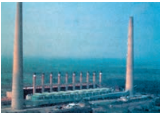
شکل ۱۶-۱- دودکش های قبلی این نیروگاه زغال سنگی با دودکش های جدید و بلند سی صد متری تعویض شده اند تا به انتشار آلودگی در جو کمک شود و از تراکم و تجمع آلودگی محلی بکاهد. این عمل ممکن است مشکلات محلی و حساسیت اهالی و ساکنین اطراف را تا حدی کاهش دهد ولی آلودگی را در سطح وسیع تری پخش می کند.
