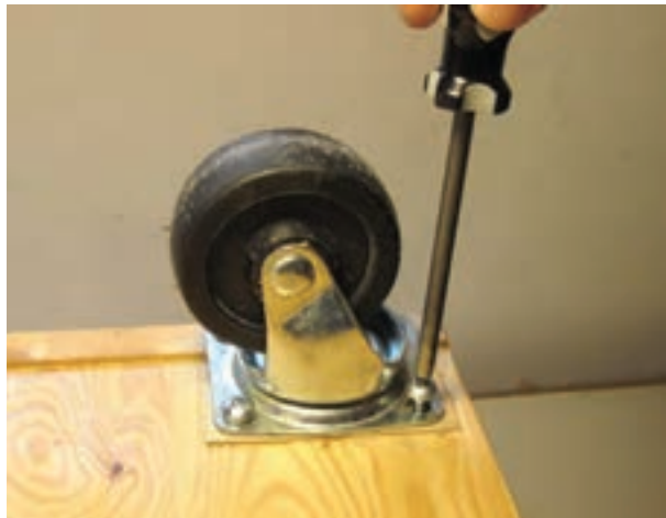
شکل ۲۵- نصب چرخ‌ها
