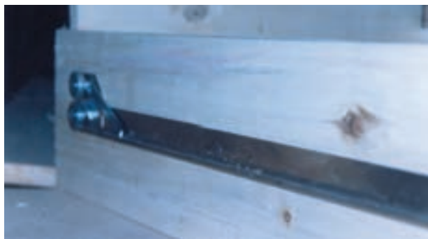
شکل ۳۰- نصب ریل روی جعبه
