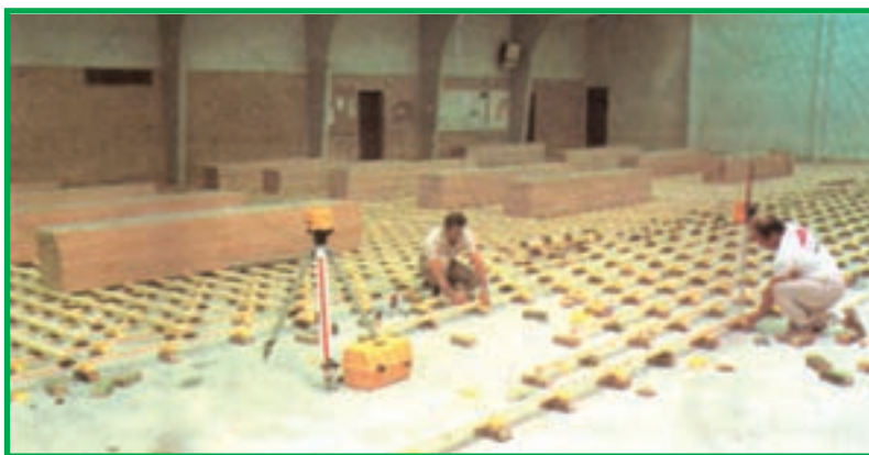
شکل ۵-۳ طریقه زیرسازی جهت نصب پارکت
