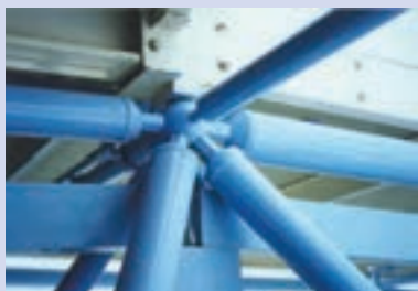
نمونه‌ای از محل اتصال اعضا (گره) در یک سازه فضایی
