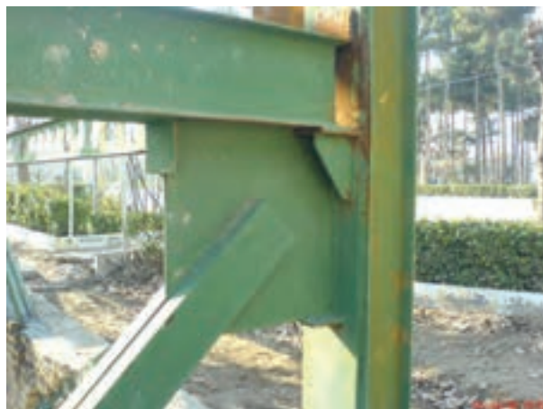
شکل ۳-۲ اتصال جوشی در سازه فلزی ساختمان
