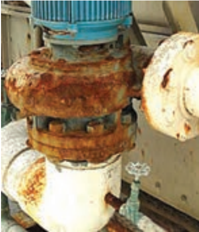
شکل ۲۵-۷- اتصالات خط لوله محتوی سیال خورنده به دلیل تماس قطعات با جنس‌های متفاوت دچار خوردگی شدید شده است.
