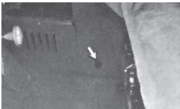
شکل ۲۱-۱-۴- کلید کنترل حرارت بخاری کف اتاق راننده
