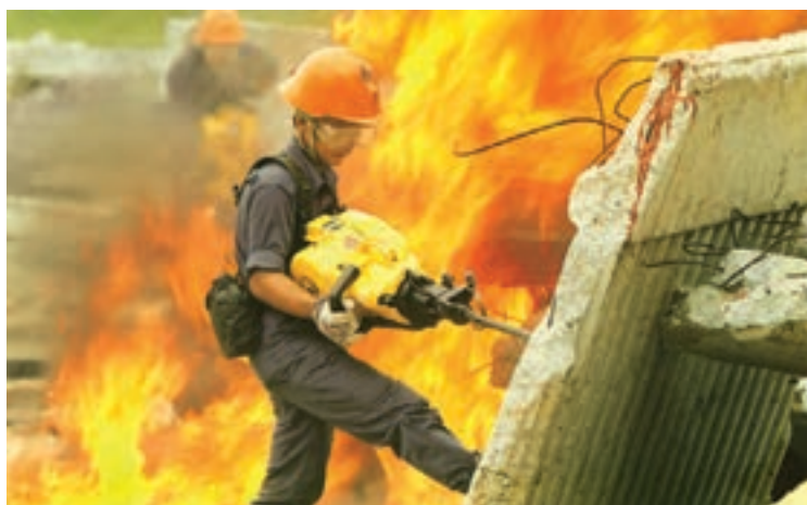
شکل ۱-۷- خرد کردن بتون
