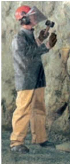
شکل ۵-۱۷- بازرسی سقف از طریق لرزش
