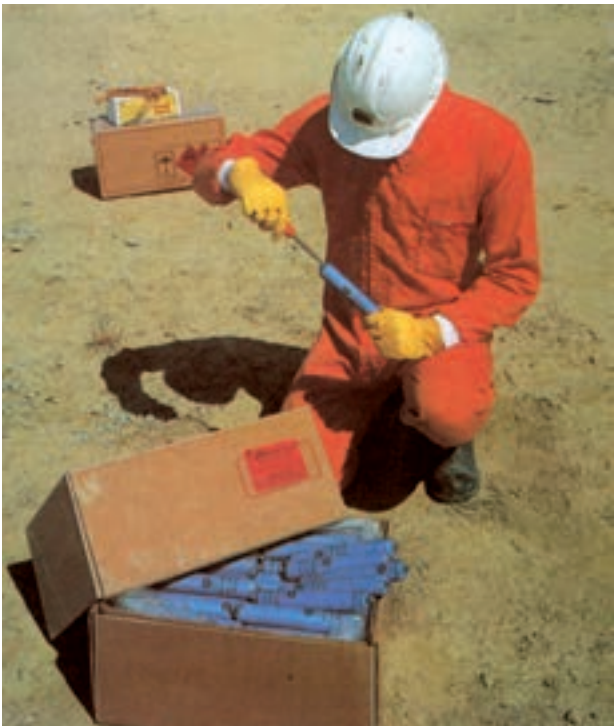
شکل ۹-۱۶- نحوه سوراخ نمودن دینامیت با درفش
