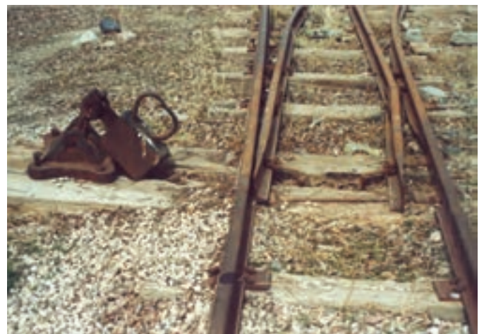
شکل ۱۱- ۳۱- انواع خطگردان و انشعاب خطوط ریل
