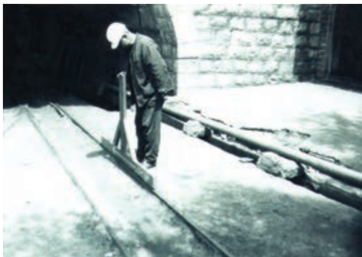
شکل ۸-۳۱- کارگر در حال اجرای روش واترپاس
