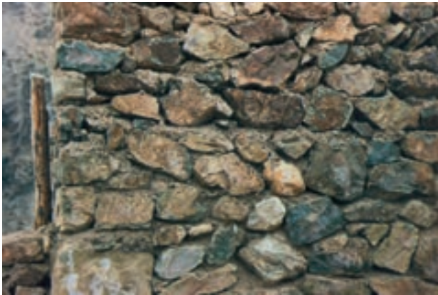
شکل ۶-۲- نمایش دیوار لاشه‌چینی با ملات
