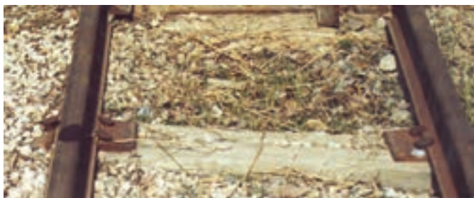
شکل ۳-۳۱- اتصال ریل به تراورس چوبی
