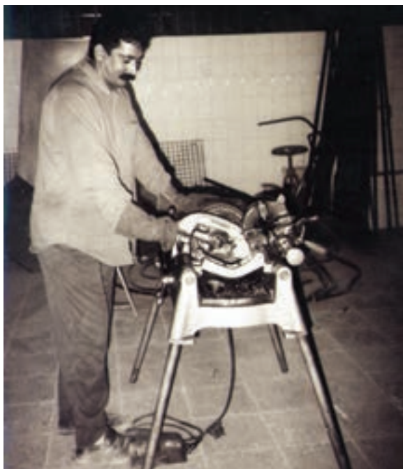
ب - نحوه‌ی حدیده کردن لوله با حدیده برقی
