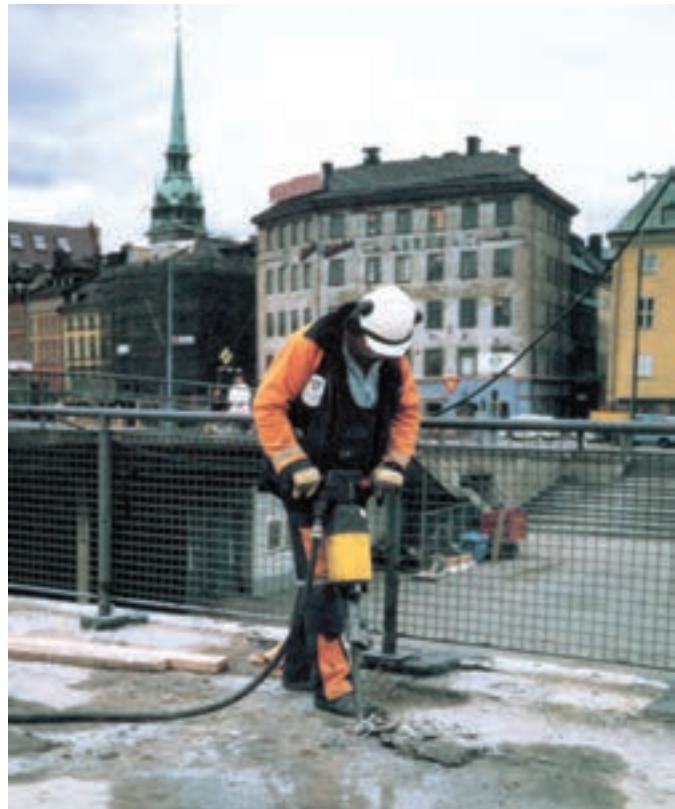
شکل ۳۸-۳- نحوه‌ی کار با انواع پیکور
