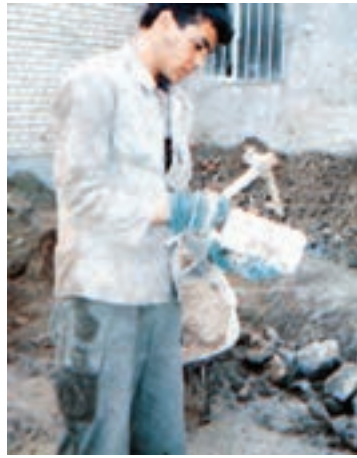
شکستن آجر به روش درست
