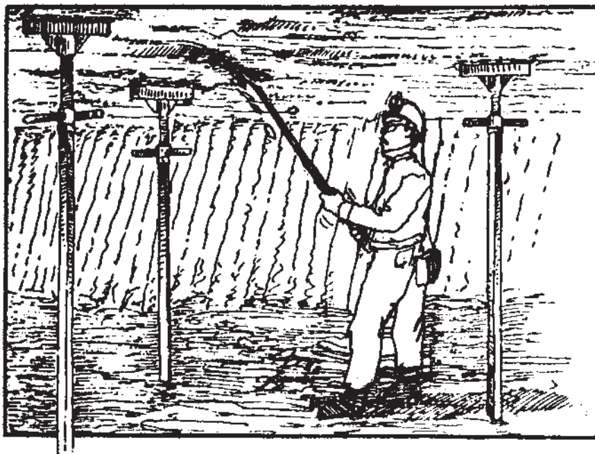
شکل ۱-۱۲- بازرسی سقف توسط وارد نمودن ضربه با دیلم
