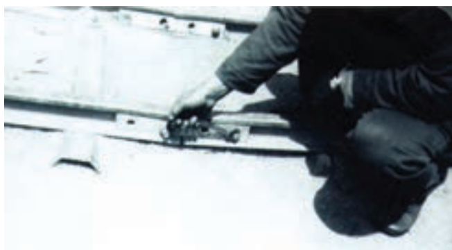
شکل ۵-۳۱ کارگر در حال بستن بغل‌بند
