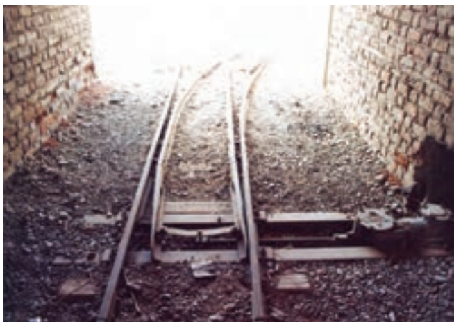
شکل ۱۱- ۳۱- انواع خطگردان و انشعاب خطوط ریل
