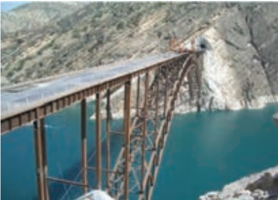
شکل ۱۵-۳— پل بزرگ کارون در جنوب کشور، قوس زیرین آن از خرپا ساخته شده است.
