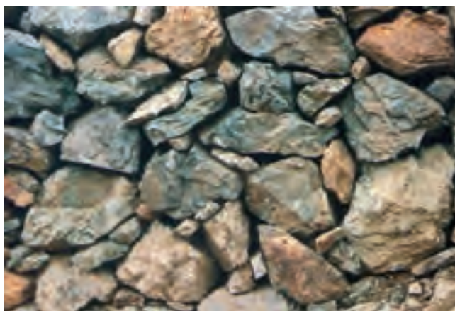
شکل ۸-۲- نمای دیوار لاشه چینی شده بدون ملات
