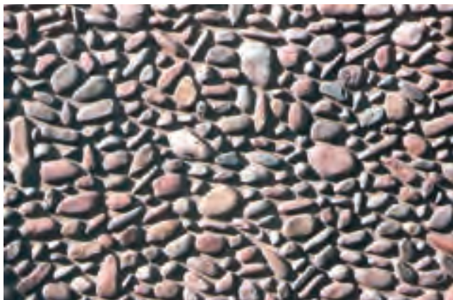
شکل ۶-۲- نماسازی با سنگ قلوه‌ای رودخانه‌ای
