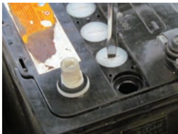
شکل ۲-۱۰۷ بازکردن درپوش خانه‌های باتری
