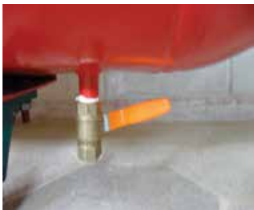
شکل ۴۵-۱۳- شیر تخلیه کمپرسور.
