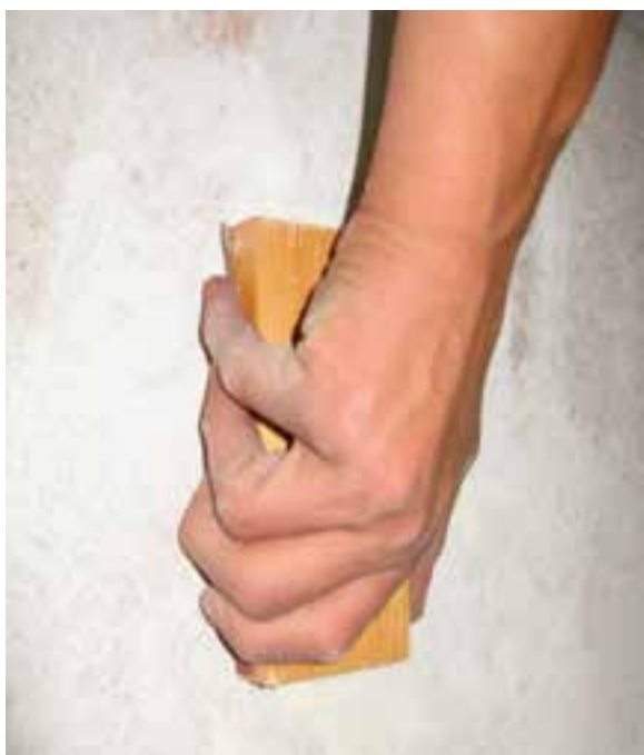
شکل ۱۹-۱۱- سنباده‌کاری سطوح ماستیک‌کاری شده.
