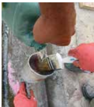
شکل ۸-۴۳- شستن پیستوله با ملال به کار رفته.
