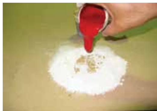
شکل ۲۴-۶- اضافه نمودن روغن الیف به بتونه روغنی.
