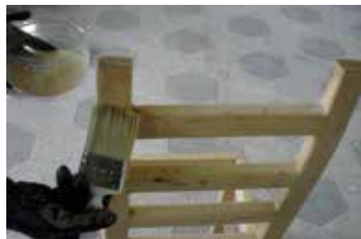
شکل ۱۳-۱۲- زدن کیلر به صندلی با قلم‌مو.
