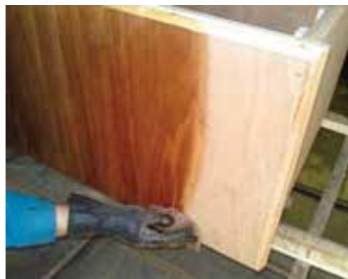
شکل ۳۱-۸- زدن آستری هم‌رنگی از پای به بالا.
