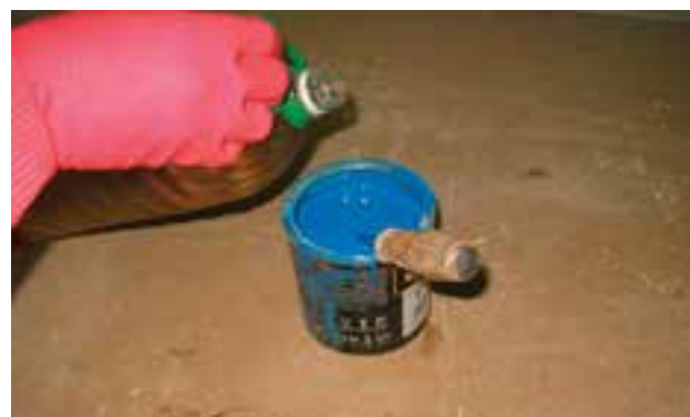
شکل ۶-۱۳- استفاده از تینر روغنی در رنگ‌های روغنی.
