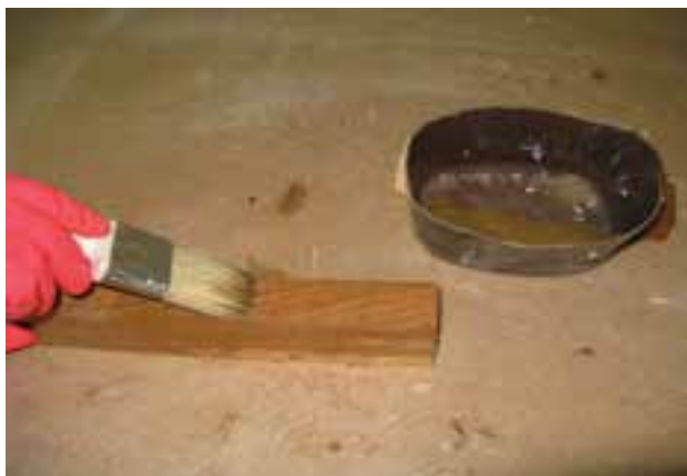
شکل ۳۹-۱۳- زدن سیلر به سطح کار با قلم‌مو.
