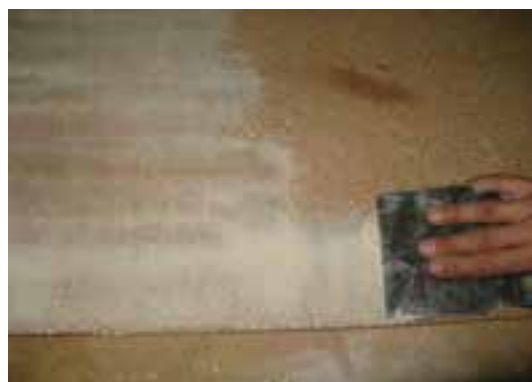
شکل ۳۵-۶- بتونه‌کاری نوع پوششی.
