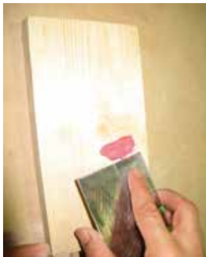
شکل ۴۷-۶- لکه‌گیری سطح کار قبل از ماستیک کاری.
