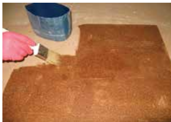
شکل ۴۹-۱۳- روغن اندود کردن سطح کار.
