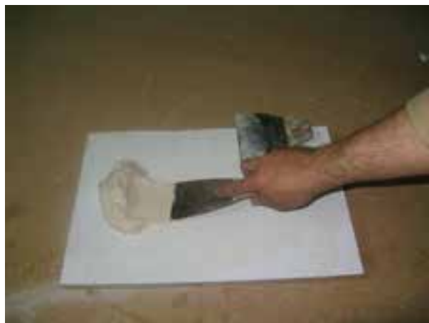
شکل ۱۸-۱۱- ماستیک‌کاری سطح کار.
