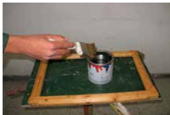
شکل ۲۷-۱۲- زدن روغن جلا با قلم‌مو به قاب آئینه.
