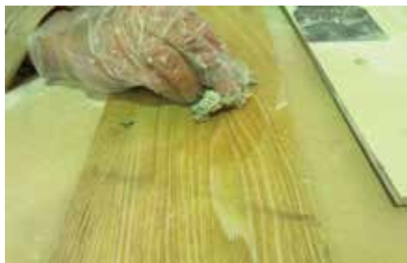
شکل ۴۰-۴- رنگ پتونه بایستی با قسمت نهادار هم‌رنگ باشد.
