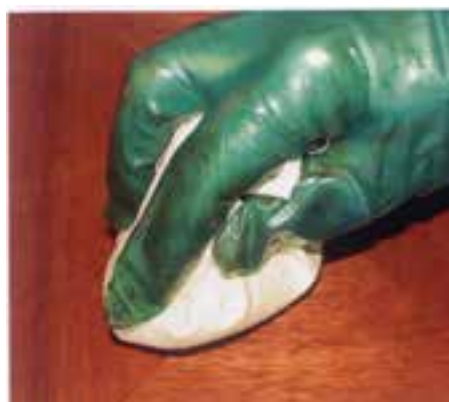
شکل ۸-۵- زدن سیلر با کهنه رنگ‌کاری.
