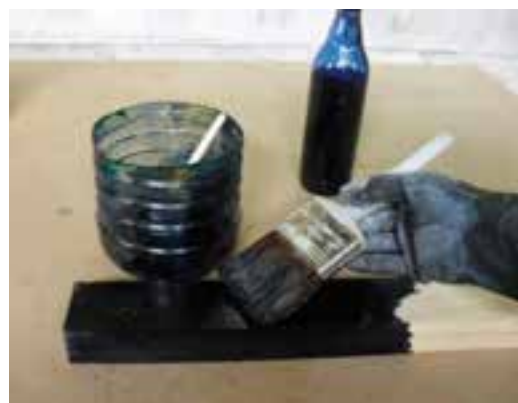
شکل ۵۴-۱۲- زدن آستری آبی (روی سطح کار).
