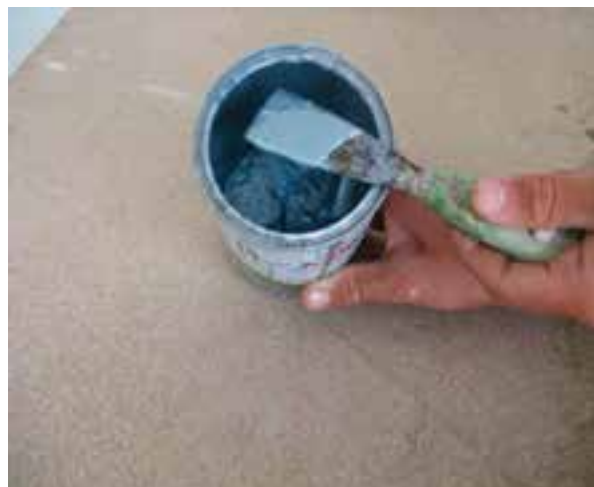
شکل ۱۳-۱۱- ترکیب اکلیل با رنگ (روغنی).
