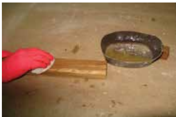
شکل ۳۸-۱۳- سیلرکاری با کهنه رنگ‌کاری.
