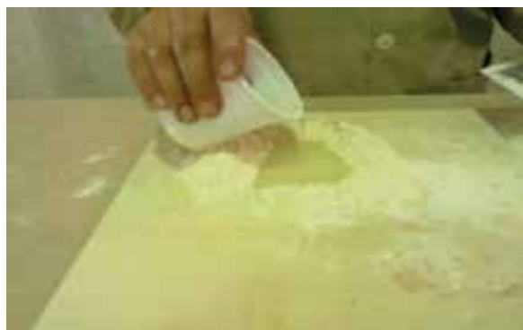
شکل ۴۸-۶- از ترکیب مل، سریش و آب بتونه سریشی ساخته می‌شود.
