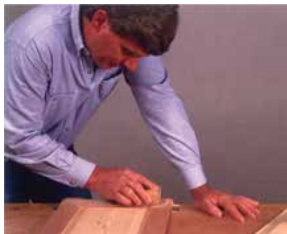
شکل ۳۸-۱۲- زدن آستری گردویی به سطح کار.
