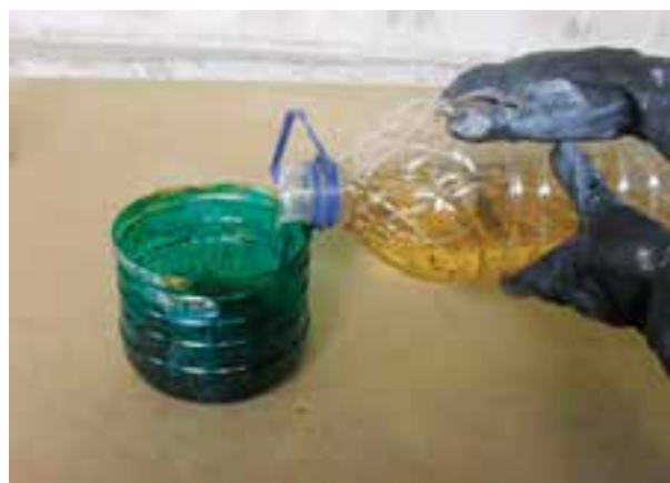
شکل ۵۰-۱۲- رقیق کردن آستری (وغنی سبز با تینر (وغنی).
