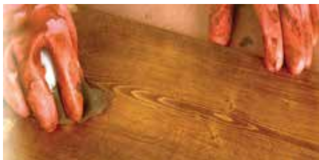
شکل ۸-۴- زدن آستری هم‌رنگی با پارچه رنگ‌کاری.
