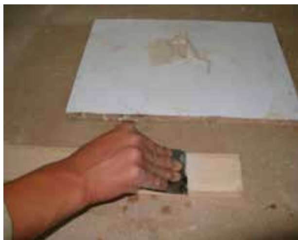
شکل ۵۹-۱۳- زدن بتونه هم‌رنگی به چوب نراد.
