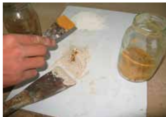
شکل ۱۳-۳۲ اضافه کردن پودر رنگی (زرد به فمیر بتونه).
