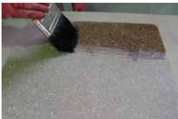
شکل ۱-۴- روغن اندود کردن سطح یک نئوپان با روغن بزرک.
