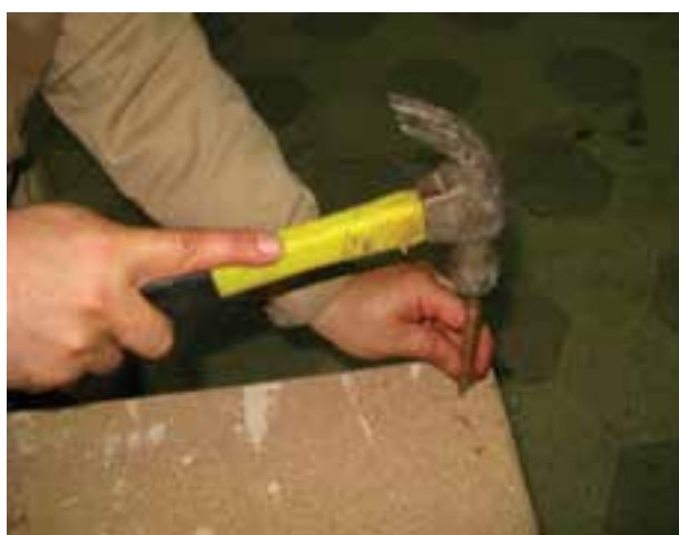
شکل ۱۷-۱۱- سنبه‌کردن میخ در یک کار پوششی.
