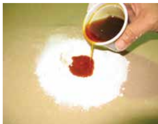
شکل ۲۵-۶- اضافه نمودن رنگ روغنی به بتونه روغنی.
