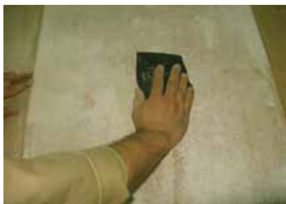
شکل ۴۹-۶- سنباده‌کاری روی سطح بتونه سریشی.
