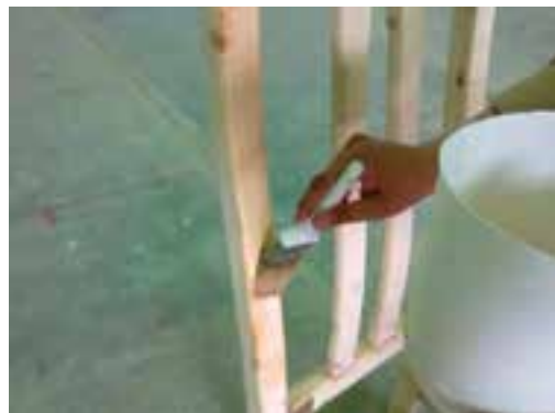
شکل ۳۶-۸- سیلر کاری از سمت بالا به سمت پایین.
