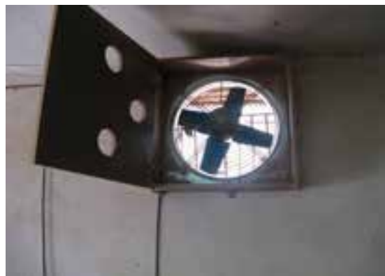
شکل ۴۷-۱۳- یک دستگاه تهویه در اتاق رنگ‌کاری.
