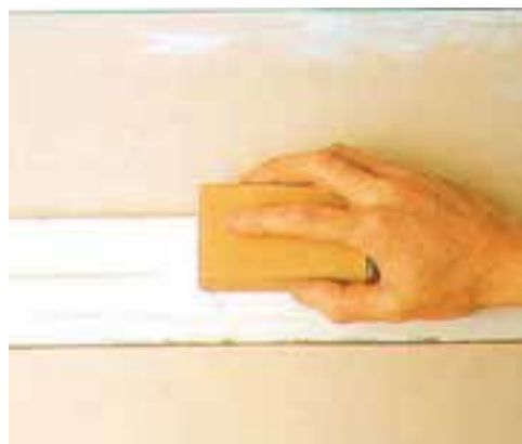
شکل ۲۱۴-۴- سن‌باده‌کاری در جهت الیاف.
