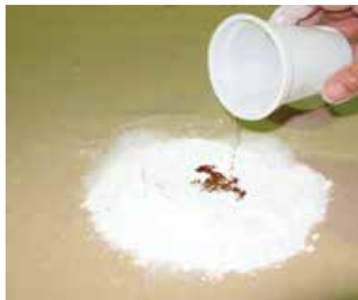
شکل ۲۳-۶- اضافه نمودن آب به بتونه روغنی.
