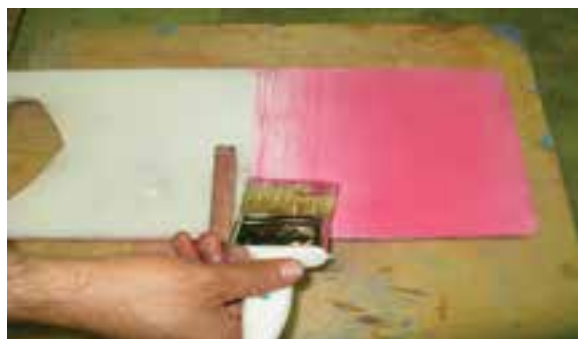
شکل ۷-۱۱- زدن رنگ (روغنی به کار) با قلم‌مو.
