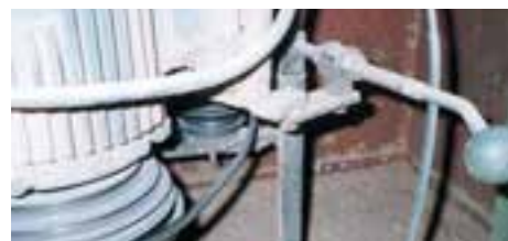
شکل ۳-۱۴. باز کردن درپوش روی تسمه‌ها.
