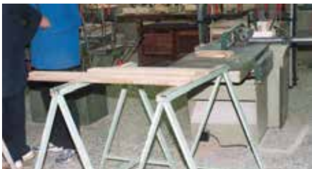
شکل ۱-۴۶-۱- قطعات چوبی آماده.
