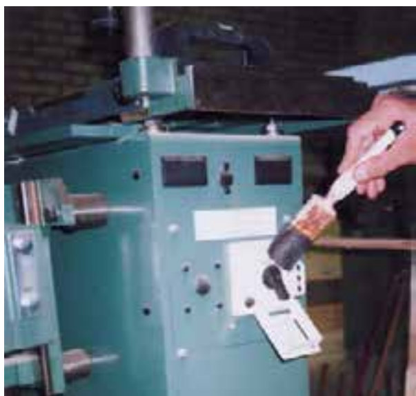
شکل ۱۵-۱- گردگیری و تمیز کردن کلید برق.
