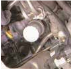
شکل (۲-۶۰) کنترل فیلتر از نظر نشتی
