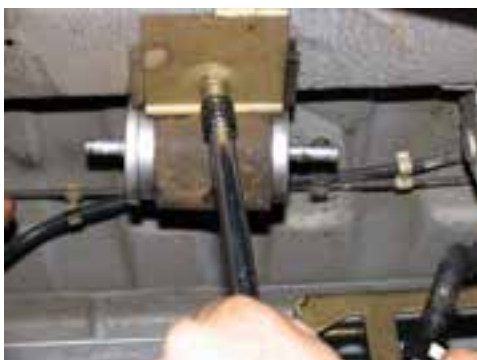
شکل (۲-۶۸) نصب فیلتر جدید
