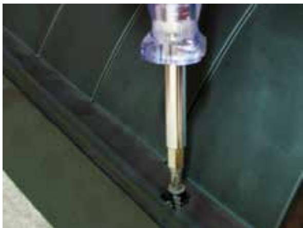
شکل ۱-۱۱۶ کاربرد پیچ گشتی
