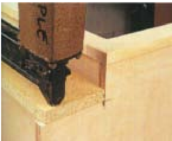
شکل ۸-۲۰- اتصال تخته خرده چوب به کابینت.
