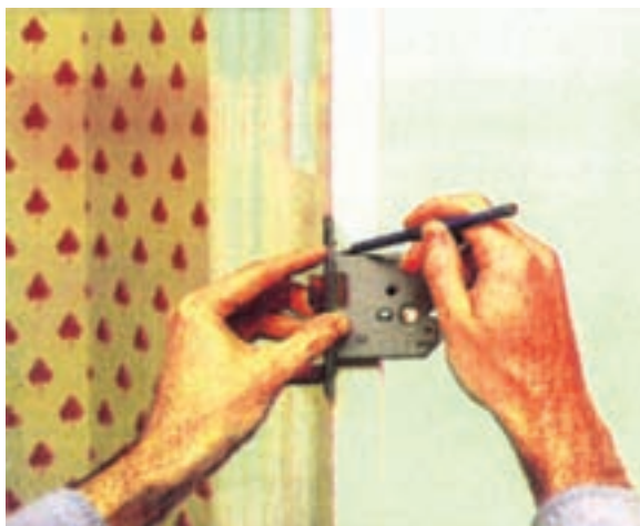
شکل ۱۰-۴۴ - فم‌کشی محل قفل (روی نر کار).
