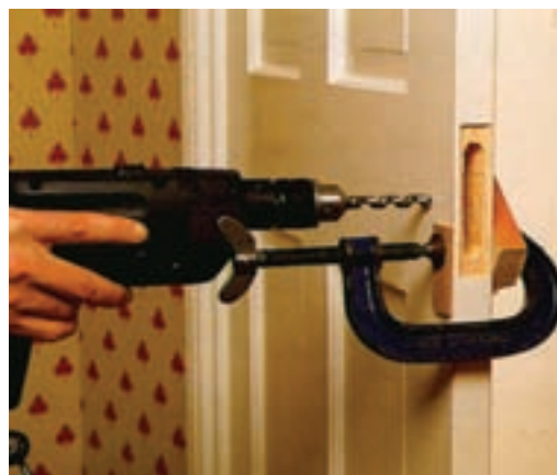
شکل ۱۰-۴۸- سوراخ‌کاری ممل پلاک و دستگیره‌ی قفل.
