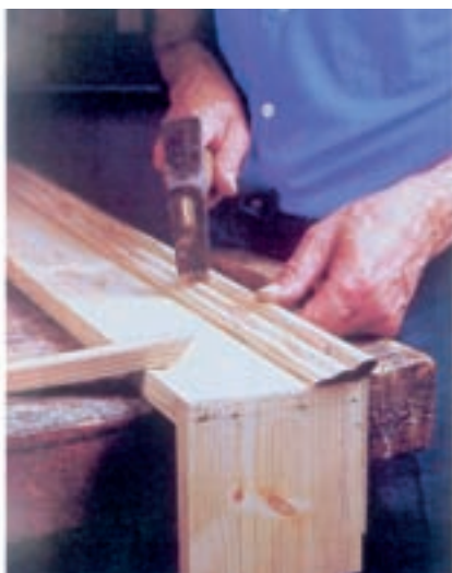
شکل ۱۰-۱۳- نصب زهوار با میغ.
