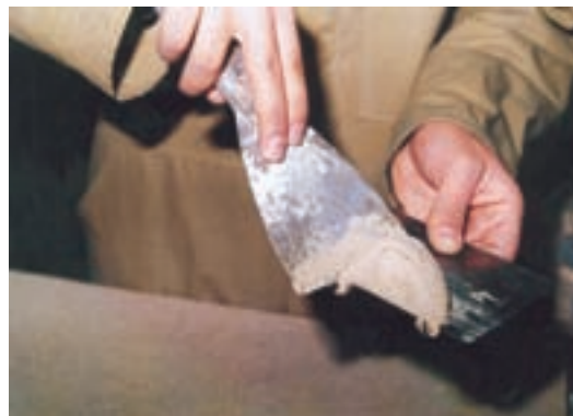
شکل ۴-۸- کاربرد لیسه و کاردک هنگام بتونه کاری.
