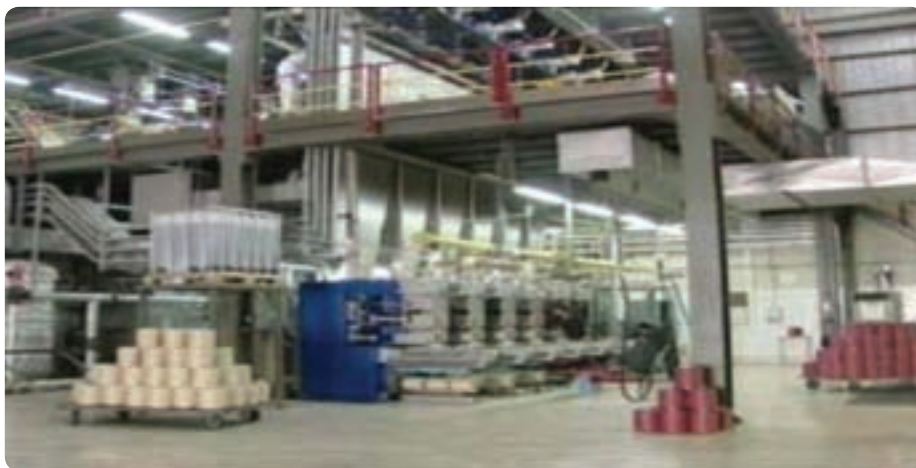
شکل ۱۵-۶- کارخانه کابل نوری یزد
