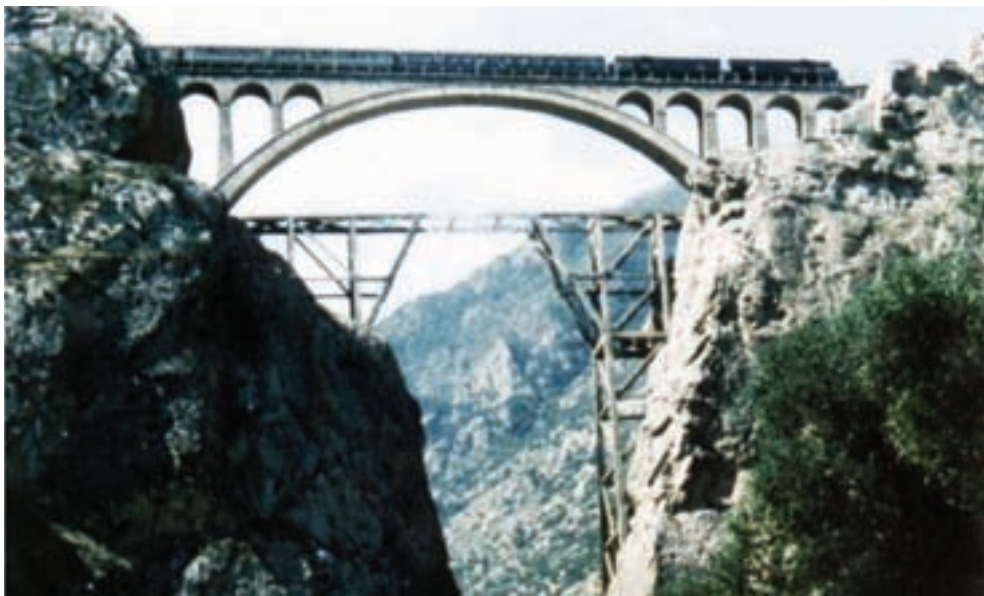
شکل ۲۸-۵- راه آهن شمال - پل ورسک
