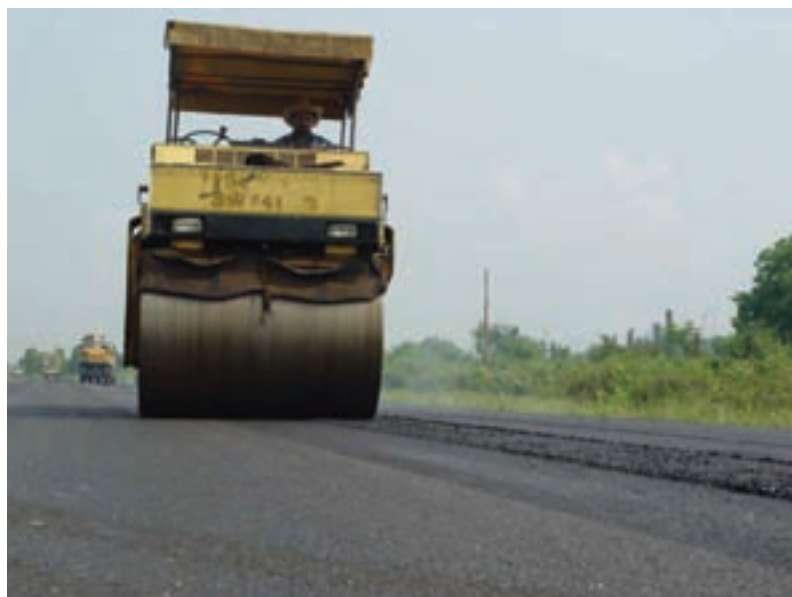
شکل ۴-۶- عملیات راه سازی
