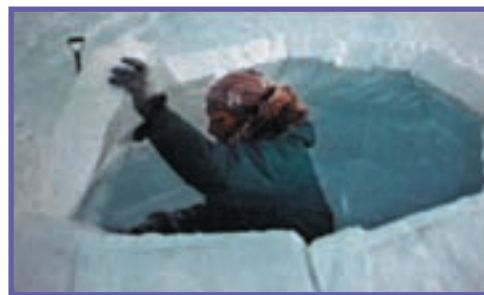
شکل ۴-ب- مراحل ساختن یک ایگلو
