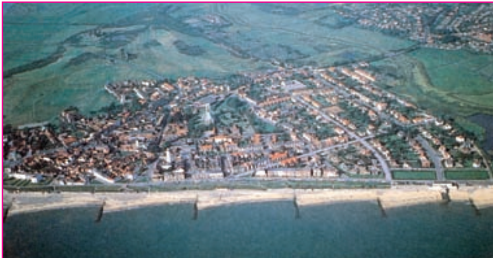
شکل ۸- احداث حفاظ در سواحل ماسه‌ای
