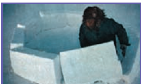
شکل ۴- الف- مراحل ساختن یک ایگلو
