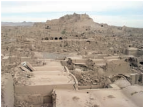
(ب) ارگ بم بعد از وقوع زلزله
