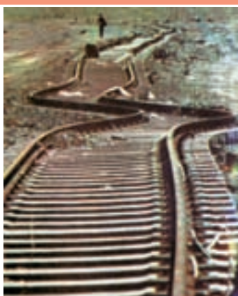
شکل ۶-۶- تخریب خط آهن بر اثر وقوع زلزله
