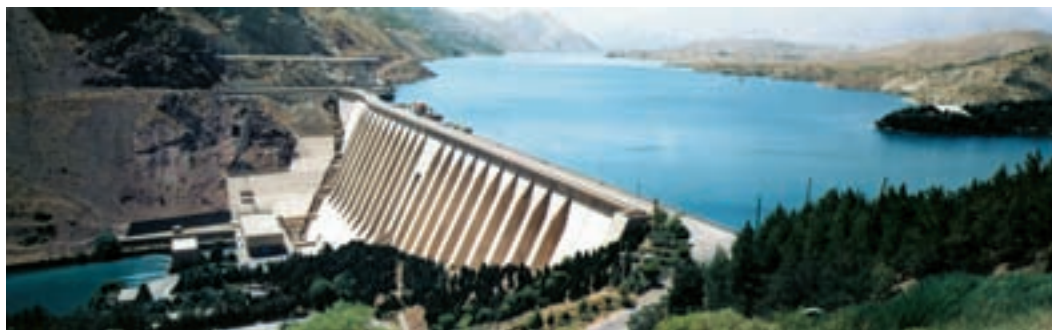
شکل ۲۸-۶- احداث سد روشی برای کاهش خطر خشک‌سالی
