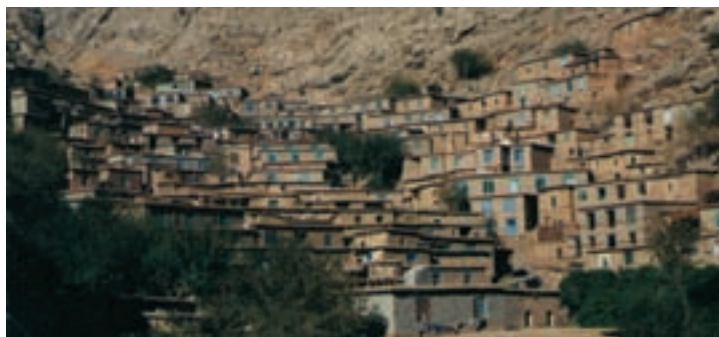
شکل ۴۰-۲- روستای پلکانی هجیج در منطقه‌ی پاوه‌ی کرمانشاه
