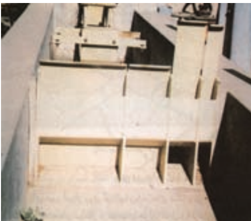
شکل ۹-۷- دریچه نیربیک
