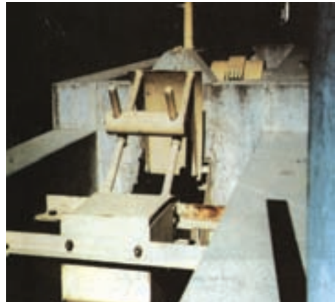
شکل ۸-۷- دریچه قطاعی و اتوماتیک
