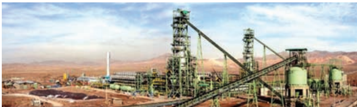
شکل ۴-۶- نمای از کارخانه فولاد خراسان - نیشابور
