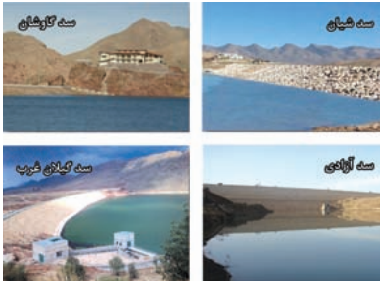
شکل ۳-۶- نمایی از برخی از سد های استان کرمانشاه
