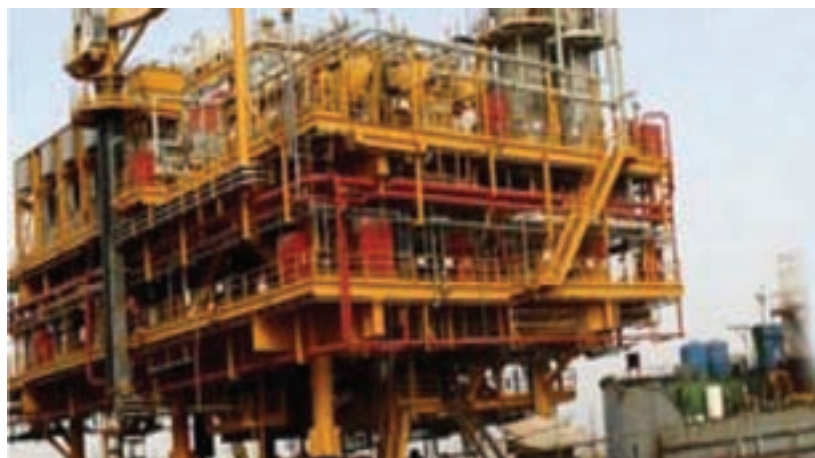
شکل ۳۷-۵- ساخت سازه و سکوه‌های دریایی در خرمشهر
