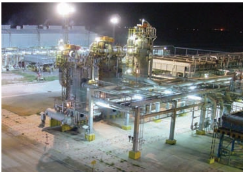
شکل ۳۲-۵- کارخانه گاز و گاز مایع شماره ۹۰۰- اهواز
