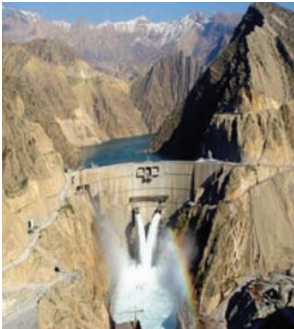
شکل ۴-۶- سد کارون ۳ بلندترین سد بتنی کشور
