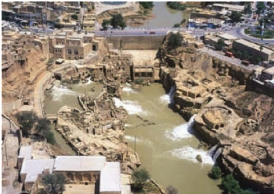
شکل ۱۳-۵- سازه‌های آبی شوستر
