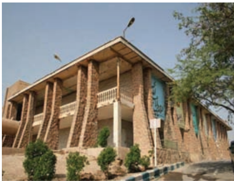
شکل ۳۰-۴- ساختمان گلف در اهواز
