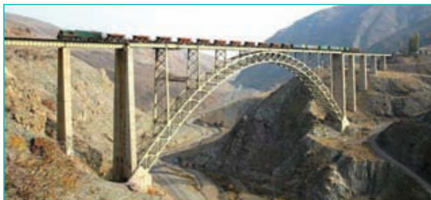
شکل ۶۶-۵- پل هوایی قطور-خوی
