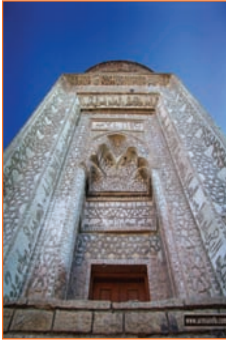
شکل ۲۴-۴- نمایی از سه گنبد ارومیه
