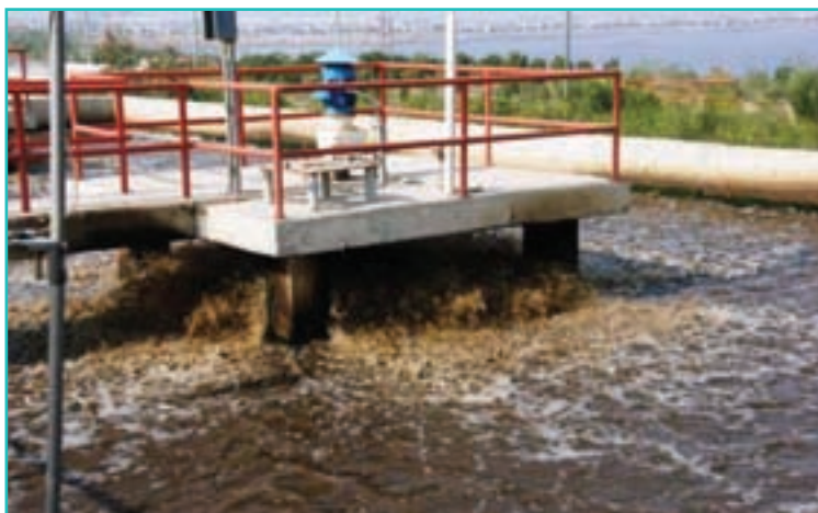
شکل ۵-۶- تصفیه‌خانه فاضلاب ارومیه
