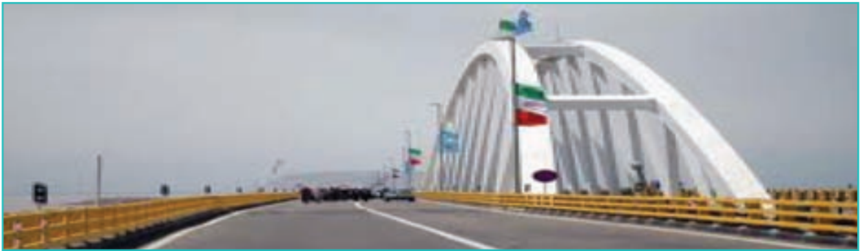
شکل ۶-۶ – پل میان‌گذر دریاچه ارومیه
