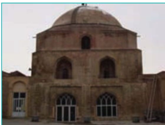
شکل ۳۳-۵- مسجد جامع ارومیه
