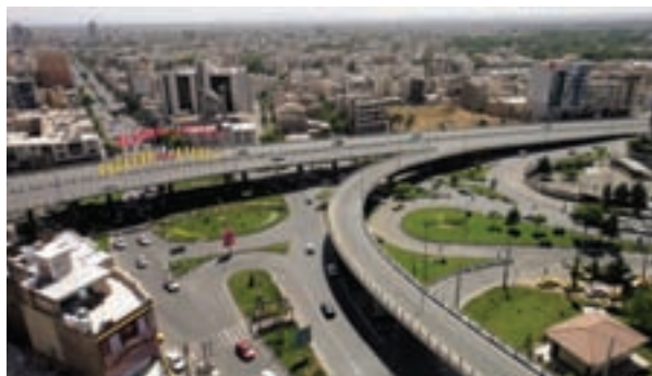
شکل ۴-۱۴- پل‌های روگذر پل آزادگان نمونه‌ای از فعالیت‌های عمرانی استان
