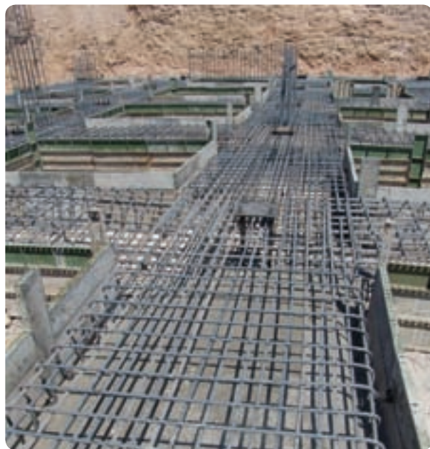
شکل ۳-۵- یکی از روش‌های کاهش خطر زلزله
