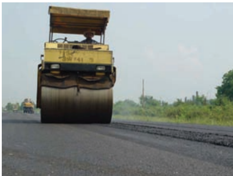
شکل ۵-۶- عملیات راه سازی
