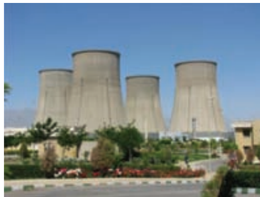
شکل ۳۶-۵- نیروگاه حرارتی شازند
