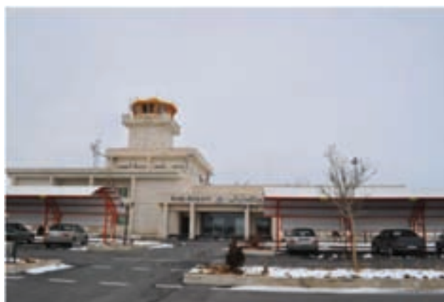
شکل ۱-۶- فرودگاه شهر اراک
