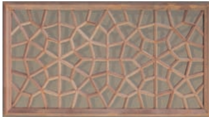
شکل ۹-۸۸- اتصال متقاطع در گره پینی یک پنجره.
