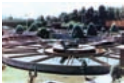
نمای بخشی از تصفیه‌خانه‌ی شهر تهران
