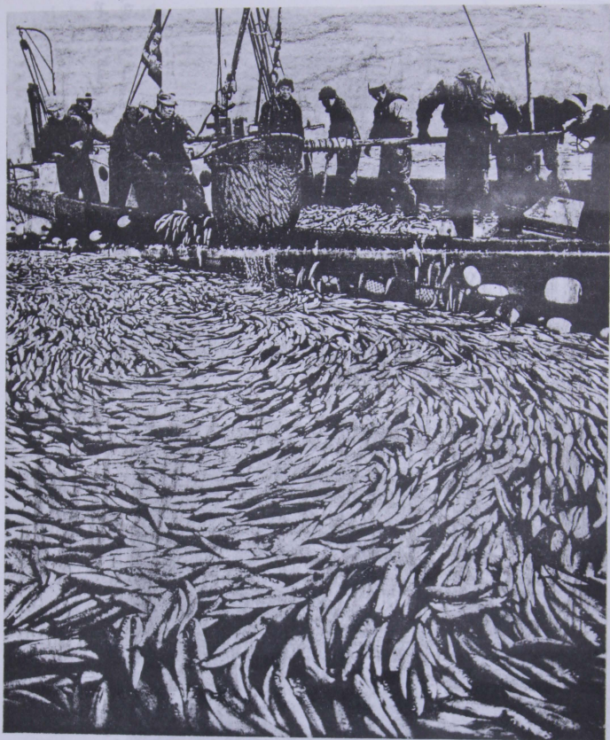
شکل ۲۰۴: عملیات بریلینگ در صید با تورهای گردان پیاله‌ای سبب سبک شدن تور می‌شود و بالا کشیدن آن را به وسیله جرثقیل امکان‌پذیر می‌سازد.
