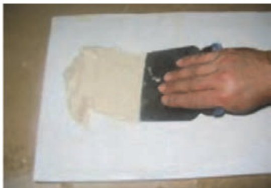
شکل ۹۱- ساخت بتونه سریشی
