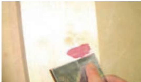
شکل ۹۳- لکه گیری قبل از ماستیک کاری
