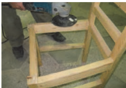
شکل ۷۲- پرداخت کاری قبل از بتونه
