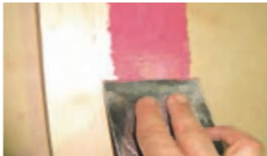
شکل ۹۲- ماستیک کاری با بتونه روغن رنگ قرمز
