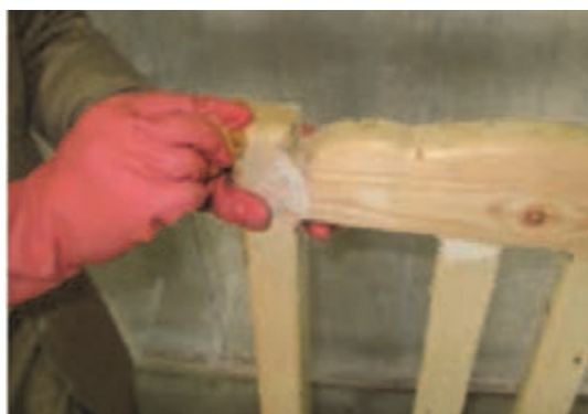
شکل ۷۱- بتونه کاری غیر پوششی
