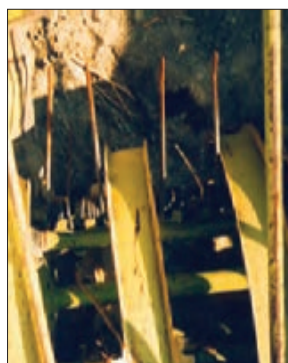
شکل ۹- پایه انگشتی شکسته
