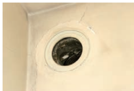
شکل ۱-۴ دودکش در محل نصب آب گرم کن.
