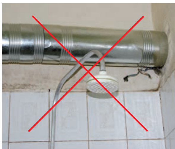
شکل ۳-۱۱ عبور غیر مجاز دودکش
