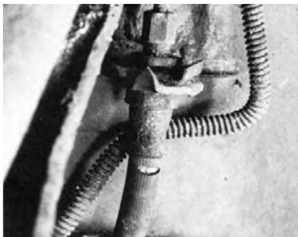
شکل ۱-۶۹- کنترل لوله‌ها و اتصالات
