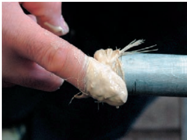
شکل ۵-۹۰- خمیر و کف کردن سردنده
