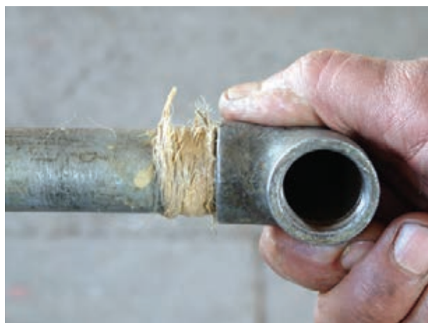
شکل ۵-۹۱- بستن فیتینگ بر روی سردنده
