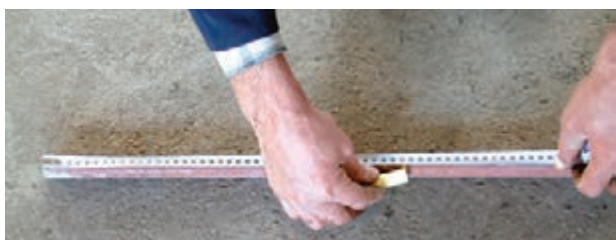
شکل ۳-۵۴- خط‌کشی لوله و تعیین محل‌های خم
