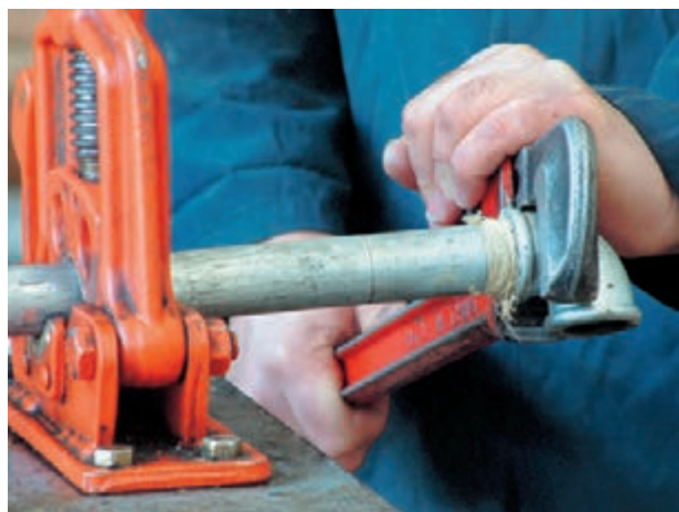
شکل ۵-۹۲- سفت کردن فیتینگ به وسیله‌ی آچار لوله‌گیر
