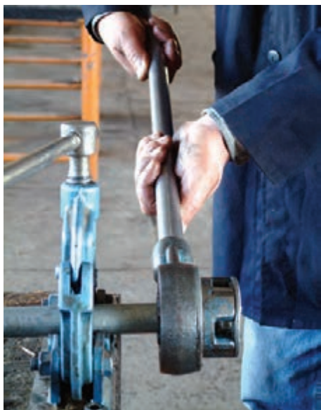
شکل ۴-۵۰- باز کردن حدیده از لوله
