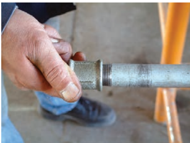
شکل ۴-۴۱ کنترل بار سردنده به وسیله‌ی یک فیتینگ
