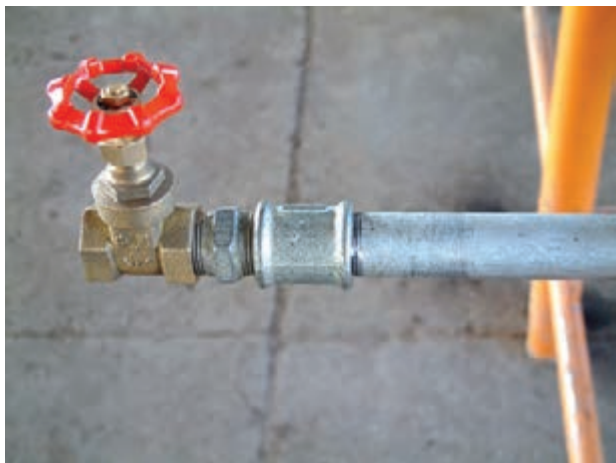
شکل ۴-۸- اتصال دنده‌ای
