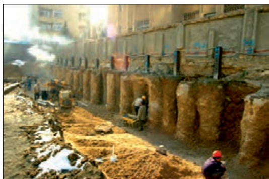
شکل ۱-۸۸ مهاربندی با پشت بند خاکی ستونی
