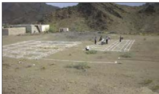
شکل ۸۳-۱ پیاده کردن نقشه روی زمین
