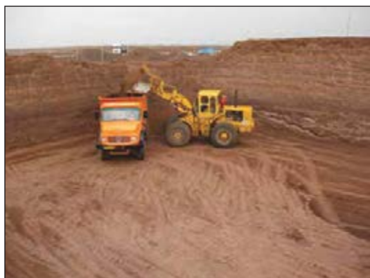
شکل ۸۵-۱ گودبرداری با لودر در زمین نامحدود
