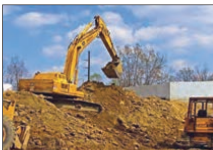
شکل ۱-۱۳- کندن زمین با وسایل مکانیکی
