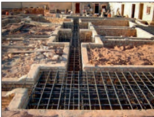
شکل ۷۰-۲ میلگردگذاری در پی کلاف بندی
