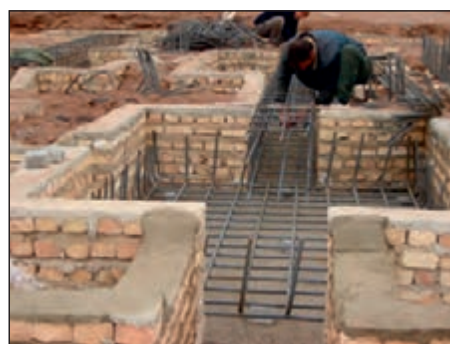
شکل ۱-۸۲ قالب‌بندی آجری در اطراف پی
