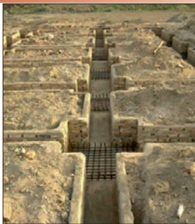
شکل ۴۸-۱ آرماتورگذاری پی تکی کلاف بندی شده
