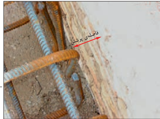
شکل ۲-۱۲۶ فاصله‌ی پوشش و قلاب سر میل‌گردها
