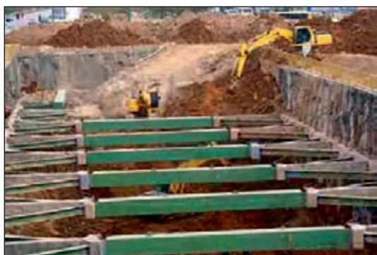
شکل ۱-۸۹ مهاربندی با پشت بندهای افقی و مایل (فضایی)
