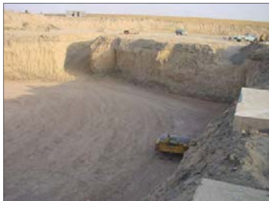
شکل ۸۴-۱ زمین گودبرداری شده
