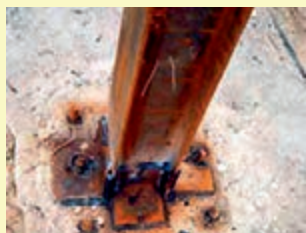
اتصال نامناسب و ضعیف ستون به بیس پلایت
