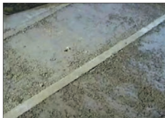
شکل ۲۱-۶ پرکردن فضای بین کرم‌ها با پوکه معدنی
