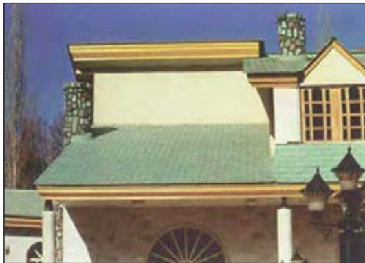
شکل ۱-۱۰۲ پوشش سقف با ورق‌های فشرده‌ی آردواز
