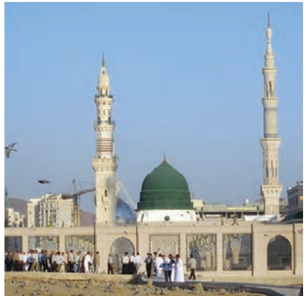
مسجد النبی، نمای بیرونی
