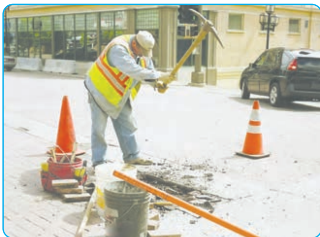
استفاده از کلنگ در کندن زمین
