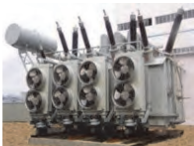
شکل ۳۹- ترانسفورماتور قدرت
