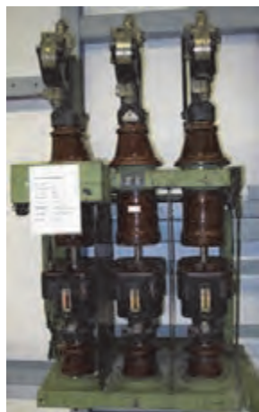
شکل ۱۶- کلید اکسپانزیون (آبی)
