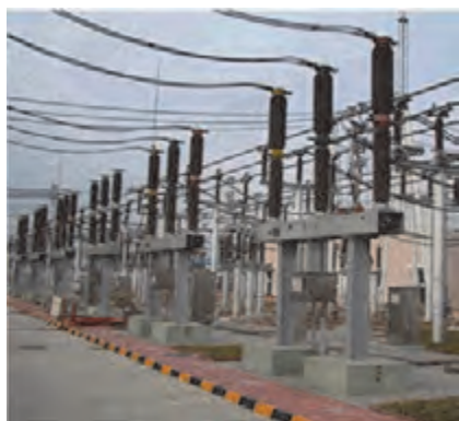
شکل ۱۸- کلید گازی \text{SF}_6
