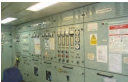
شکل ۱۶ - سویچ برد اصلی شناور
