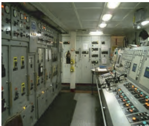
شکل ۳۶- تابلو توزیع یک شناور
