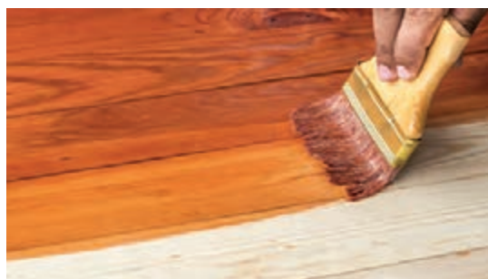
شکل ۶۲- آستری زدن با قلم‌مو
