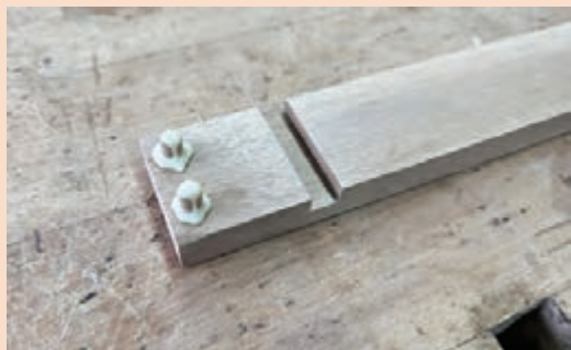
شکل ۲۳۰- چسب زنی میخ چوبی محل اتصال
