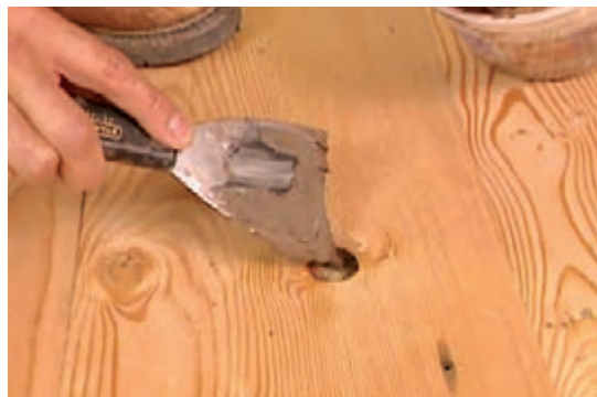
شکل ۵۴- بتونه کاری ترک گره چوب
