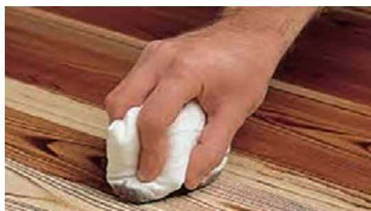
شکل ۶۳- آستری زدن با کهنه رنگ‌کاری
