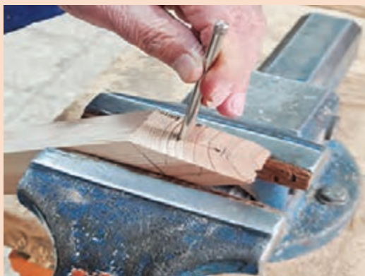
شکل ۱۰۹- محل علامت‌گذاری دوبل و سنبه زدن
