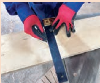
شکل ۱۸۵- خط کشی محل برش با گونیا و مداد
