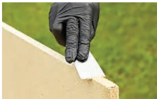
شکل ۵۹- بتونه کاری لبه با کاردک
