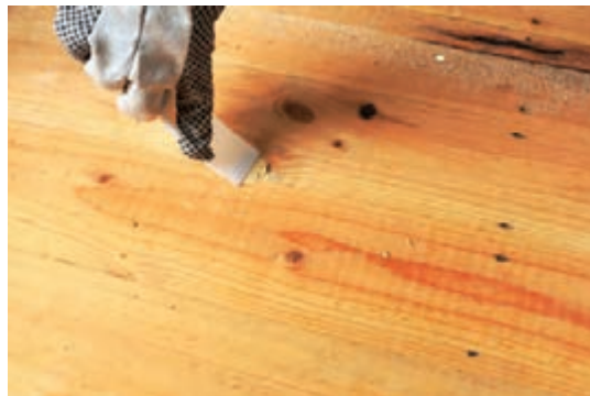
شکل ۵۳- بتونه کاری منافذ سطح چوب
