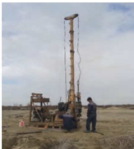
شکل ۳-۶- حفاری گمانه اکتشافی توسط دستگاه حفاری
