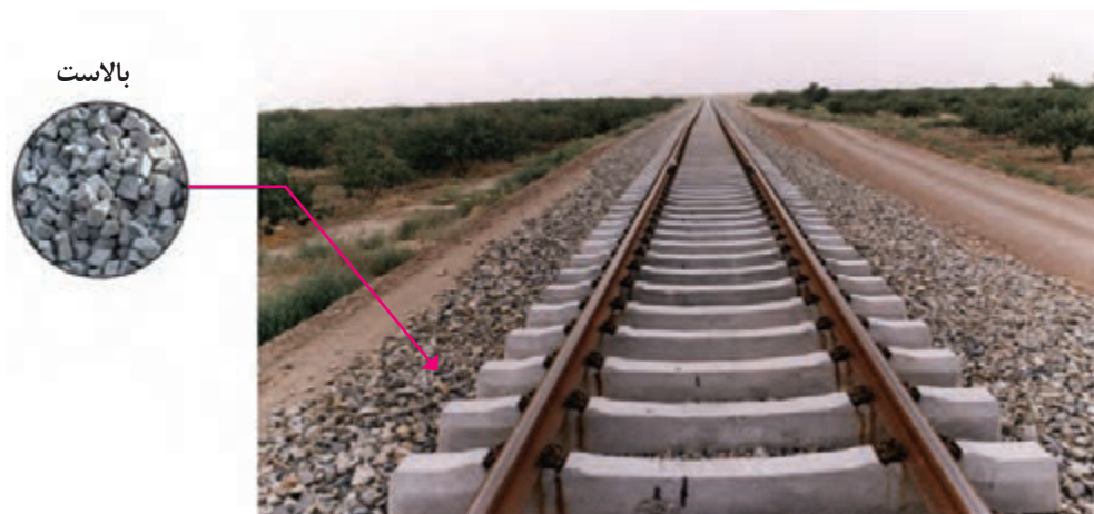
شکل ۶-۲۲. بالاست استفاده شده در زیرسازی جاده ریلی
