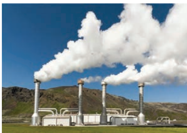
شکل ۱۱-۴- نیروگاه زمین گرمایی مشکین شهر - اردبیل
