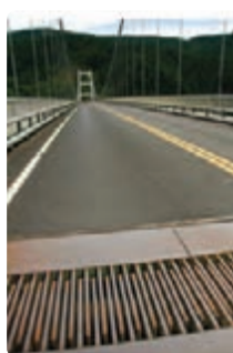
(ب) نمونه‌ای از بست‌های انبساطی
