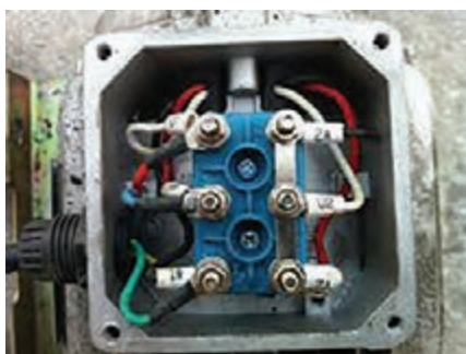
شکل ۳- پلاک اتصالات موتور الکتریکی
