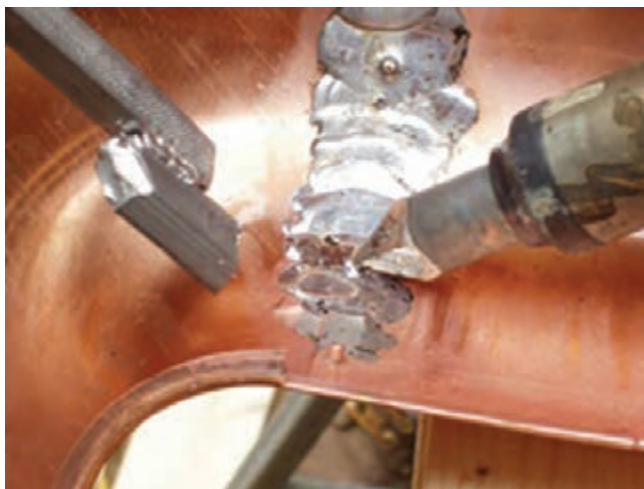
شکل ۳۰- پرکردن درز اتصال به وسیله مذاب لحیم
