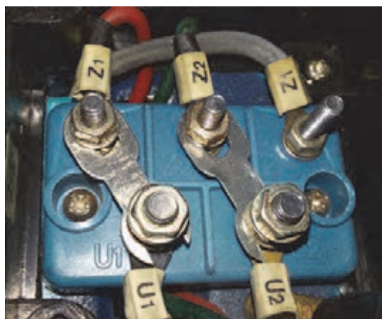
شکل ۵- تخته کلم موتور تک فاز
