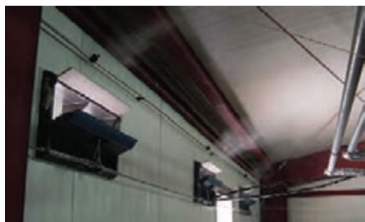
شکل ۲۲- نحوه خنک شدن هوا توسط سیستم نازل مه پاش
