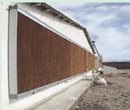
شکل ۲۱- سیستم فن و پد و نحوه خنک شدن هوا توسط آن
