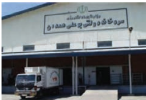
شکل ۲-۶- سردخانه بوعلی - همدان
