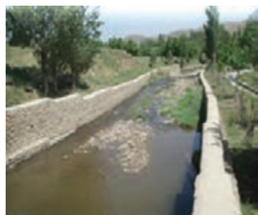
شکل ۱-۶۴ دیوار حاشیه رودخانه
