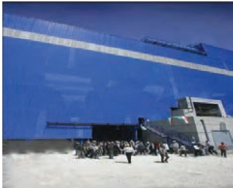
شکل ۱۸-۵- مجتمع فولاد ویان - کبودرآهنگ
