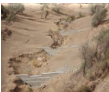
شکل ۱-۶۳ بند گابیونی (سنگ‌ها در تور سیمی)
