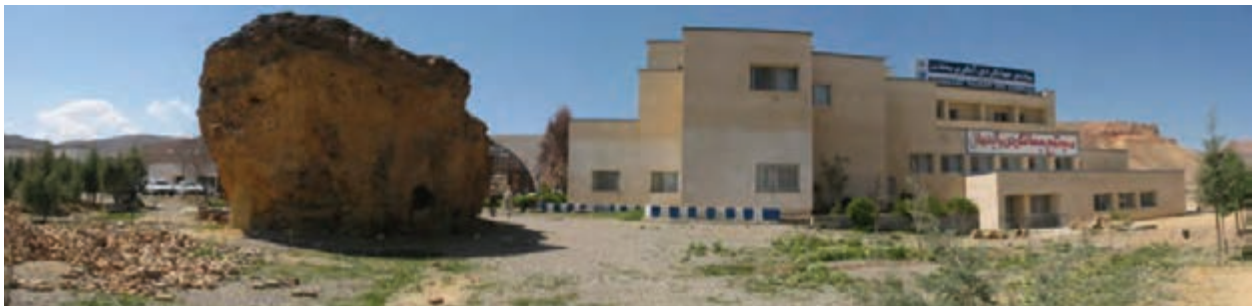
شکل ۵-۵ مجتمع آبگرم محلات
