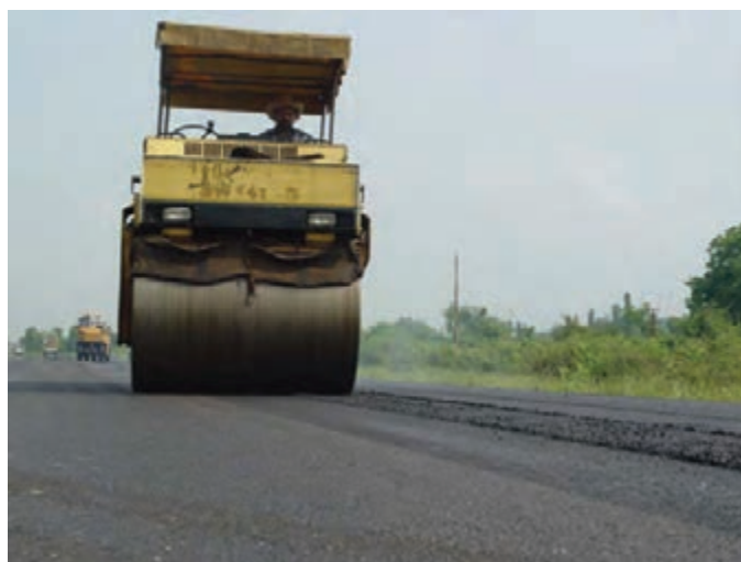
شکل ۴-۶- عملیات راه سازی
