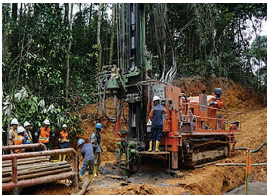
شکل ۲۳- دستگاه آر سی در حین عملیات حفاری
