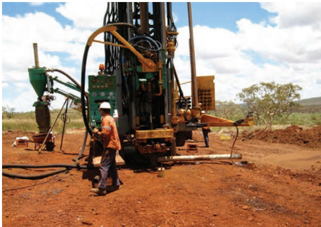
شکل ۱۸- دستگاه حفاری RC
