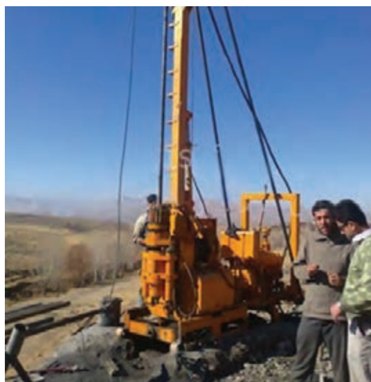
شکل ۹- دستگاه حفاری مستقر شده بر روی فونداسیون
