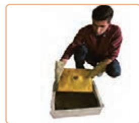
ط) قرار دادن قالب در درجه و پر کردن فضای خالی اطراف با استفاده از ماسه پشت‌بند
